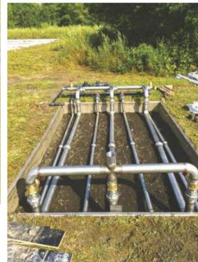
Sur cette parcelle sont testés les procédés d'oxydation et de venting.
